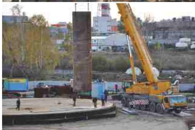
После приведения рулона в вертикальное положение, он устанавливается на подготовленное основание из пандусов и листов металла, покрытых смазкой.
