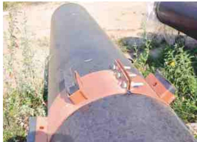
Опорно-направляющее кольцо представляет собой изделие из тонколистовой стали, с закрепленными на нем наконечниками из твердой пластмассы. Оно служит в качестве направляющей при проталкивании трубы и предохраняет изоляционное полиэтиленовое покрытие трубы от повреждений, а затем, до конца срока службы, является опорой для рабочей трубы. Эти опоры распределены по трубе шагом 3 метра.
