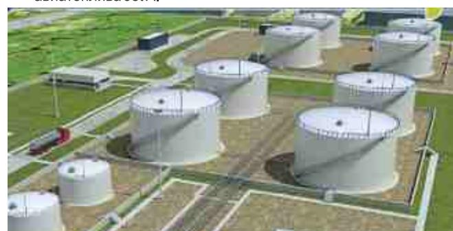
Вертикальные стальные резервуары со стационарной крышей без понтона. Стенка рулонная, с припуском на коррозию в 1 мм. Днище полистовое, с уклоном внутрь и припуском на коррозию 1 мм. Стационарная крыша коническая, щитовая. Двойное дно с вакуумным контролем герметичности и уклоном внутрь до 5 %
