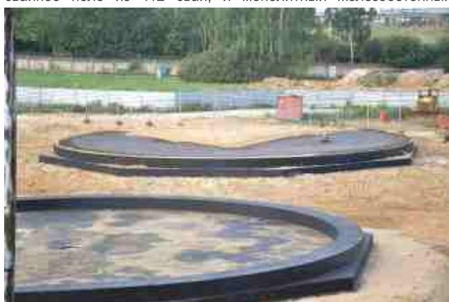
растверк. После устройства монолитного растверка, внутреннее пространство кольца засыпано крупным песком и выполнено гидрофобное основание. Поверхность растверка и бетонной подливки под зумпф зачистки покрыты битумом. Затем, на подготовленное гидрофобное основание уложены элементы днища, выполнена их сварка, и проведена проверка швов на герметичность и рентгеновский контроль их качества.
