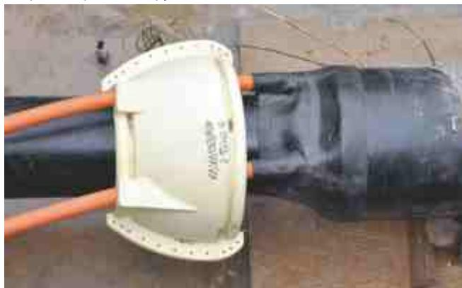
Согласно проекту, пространство между трубой и футляром герметизируется резиновыми манжетами, исключающими проникновение грунтовых вод.
