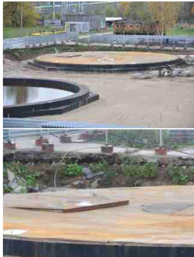
Устройство дополнительной оснастки – пандусов. Особенность монтажа вызвана крутым уклоном- 1:20. Пандусы необходимы для обеспечения устойчивости рулона при развертывании резервуара. Крупно показаны пандусы, представляющие собой металлоконструкции призванные компенсировать уклон. Погрузочно-разгрузочные работы велись автокраном Либхер грузоподъёмностью 200 т.
