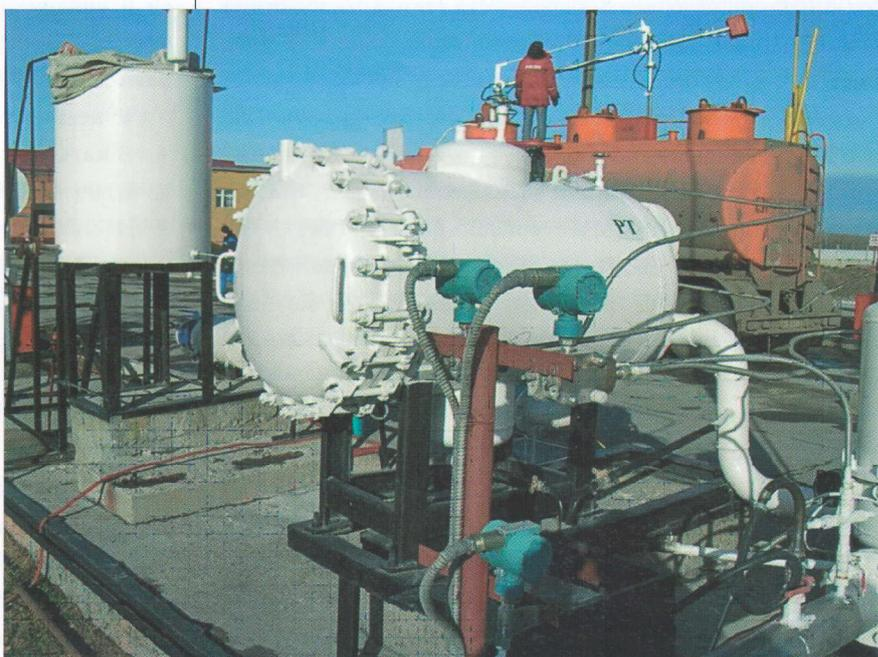
Рис 4. Фильтрующий элемент оборудованный датчиками дифференциального давления
