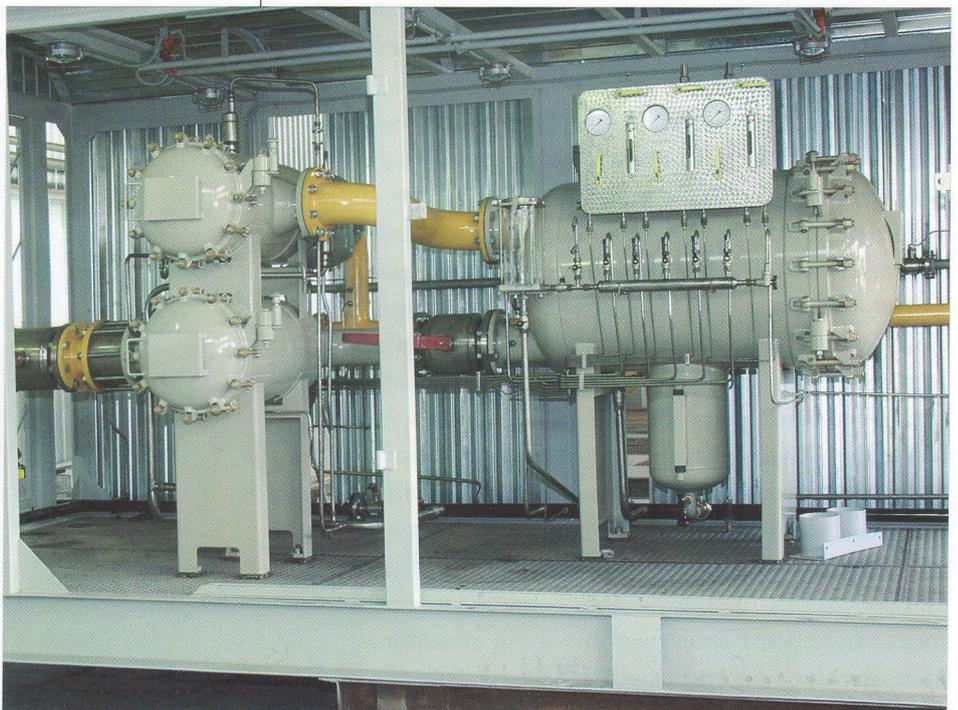
Трёхступенчатая система фильтрация на пункте налива ТЗ
